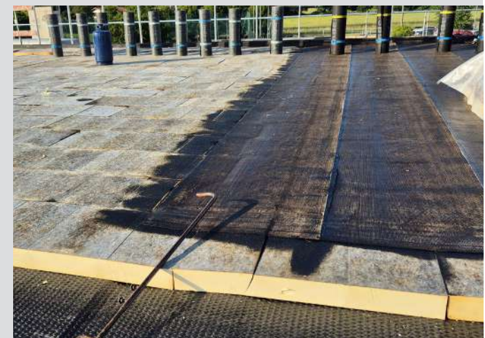
Posa isolamento termico
