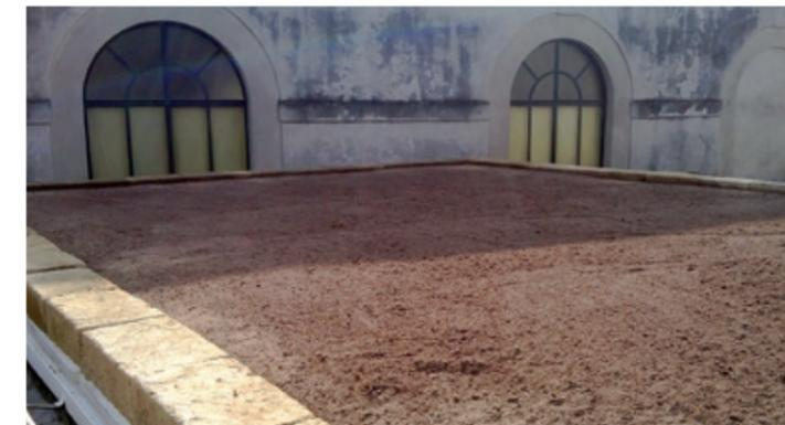
I **tetti verdi intensivi** sono i più complessi e si possono paragonare a veri e propri giardini sollevati, con percorsi pedonali, alberi ed attrezzature ricreative come panchine e tavoli. In questo caso è necessario un substrato dallo spessore consistente e con un conseguente aumento delle sezioni delle strutture portanti. La manutenzione è simile a quella degli spazi pubblici tradizionali e necessita di sistemi di irrigazione, manutenzione continua e potature.
