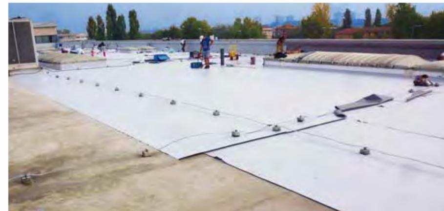
Sovracopertura dell'impermeabilizzazione esistente di un edificio commerciale con un nuovo manto impermeabile sintetico.
