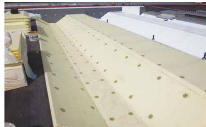
Canale di un edificio commerciale mediante la chiusura dei lucernari a nastro con pannelli sandwich, la posa di un nuovo pannello termoisolante e l'applicazione di un manto continuo sintetico.
